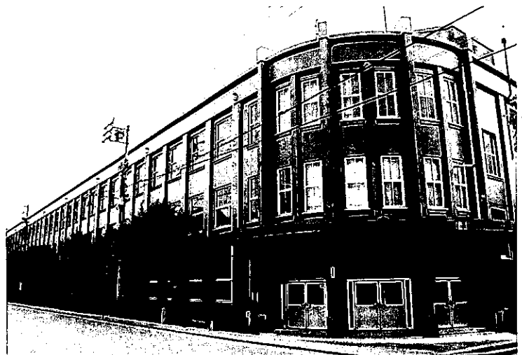
飯田市立追手前小学校校舎 昭和4年建設 鉄筋コンクリート3階建て 昨年国の登録文化財になりました。
