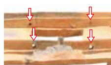
上から孔を見る
